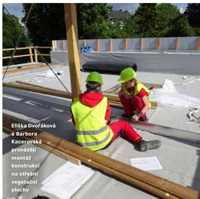
Vegetační plochy po dokončení
